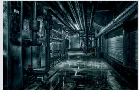
Alexander Bauer »Klimazentrale«
